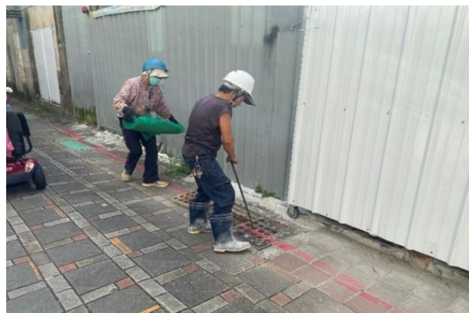
▲現場鋪設網子
